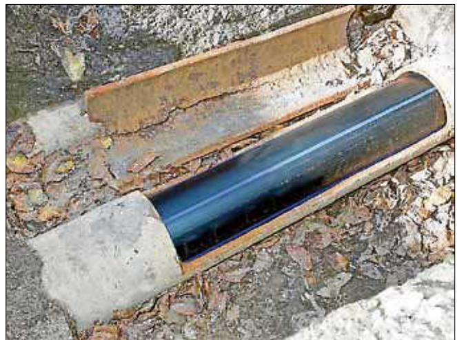
Inliner, das sind neue Kunststoffrohre, die in alten Wasserleitungen eingezogen werden, vermeiden aufwändige Aufgrabungen.
