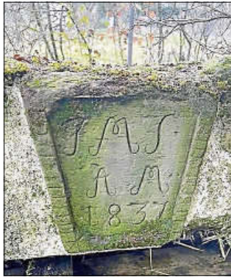
Der Türsturz vom 1837 errichteten Gebäude Kirchstraße 28
